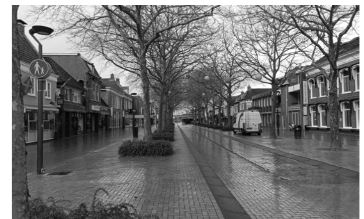
Afbeelding 60: Bestaand boomedak langs de kade
